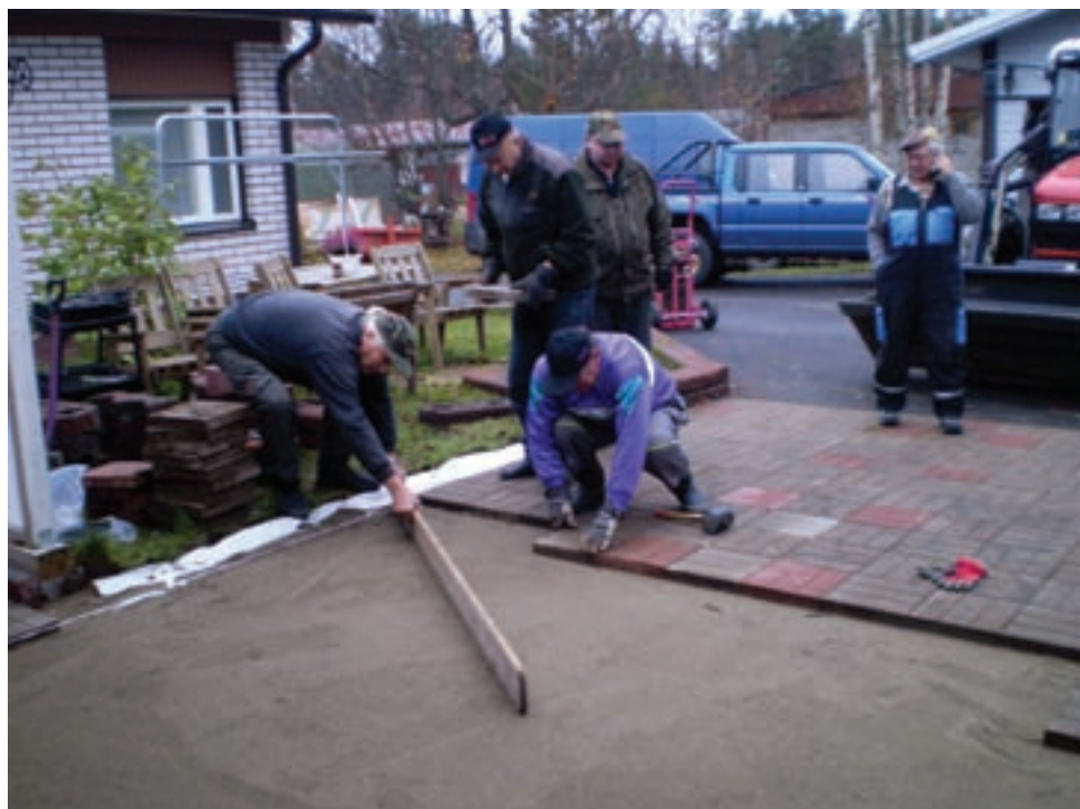
Kuvassa lionit ovat auttamassa Pekka Peltomaata pihanlaatoitustyössä.
