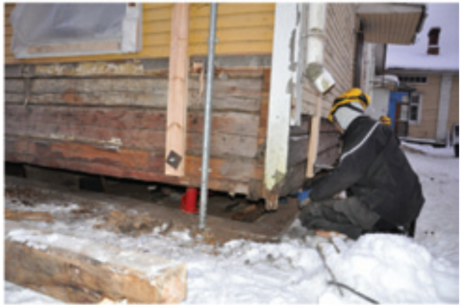
Langin alakartano nostettiin tunkkien avulla ilmaan lahonneiden hirsien vaihtamiseksi.
