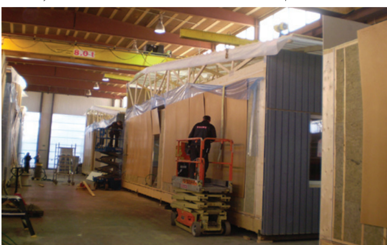
Ja kattotuolien asentamisen jälkeen paketti on käärimistä vaille valmis.
