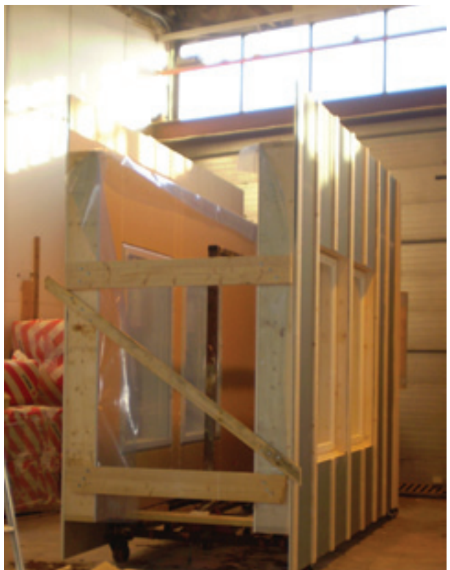
Lattiaan liitetään erillään rakennetut seinäelementit.
