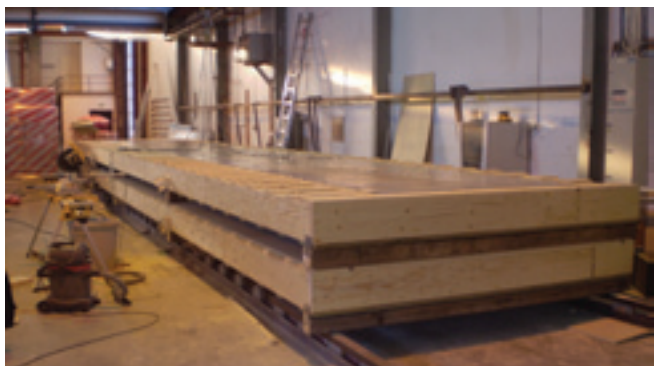
Lattia on tilaelementin perusta.
