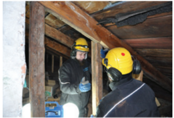
Kattorakenteisiin asennettiin lisätukea, jotta hormirakenteet saatiin pysymään ehjänä rakennusta nostettaessa.
