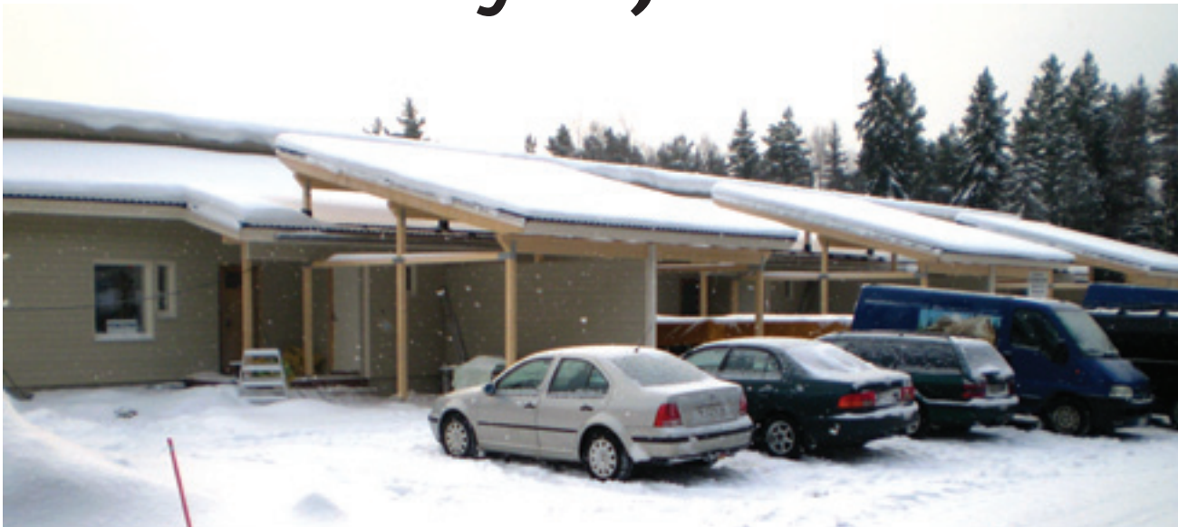
Rose Keittiöt rakentaa parhaillaan mm. rivitaloa Annalantielle. Asukkaat pääsevät muuttamaan uusiin huoneistoihinsa maaliskuun lopussa.
