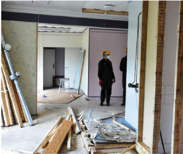
Korjaustyöt Langin kartanon sivurakennuksessa, Raahessa
