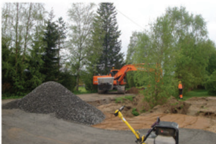
Koulun rakennustyöt käynnistyivät keskiviikkona 4.6.2014
