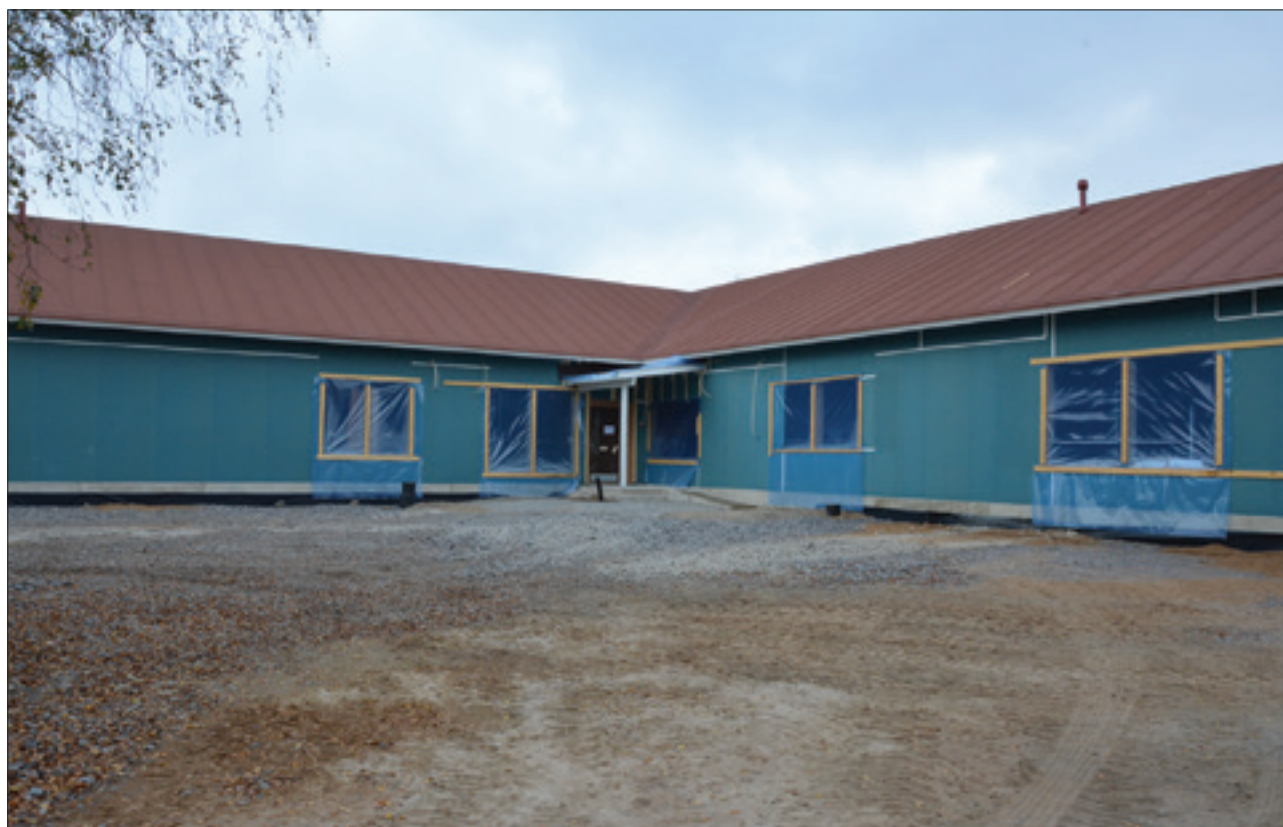
Yppärin uusi koulu on saanut jo katon päälle.
