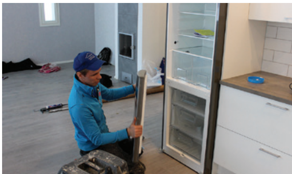
Rakentaminen tarjoaa monenlaisia tehtäviä. Tässä Esa Impola asentamassa kylmäkalusteita.
